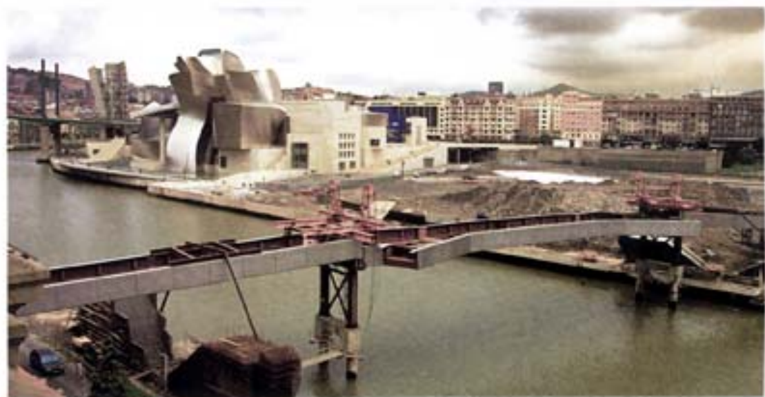
Montaje por flotación e izado del tramo central.
