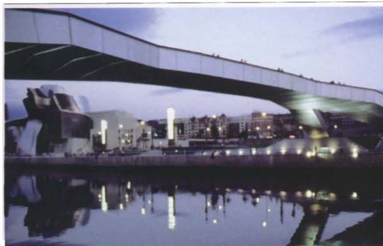
Fig. 111. Puente de Abandoibarra. A. Aguirre, I. Garmendia y I. Izquierdo. Estudio: Estudio Guadiana.
