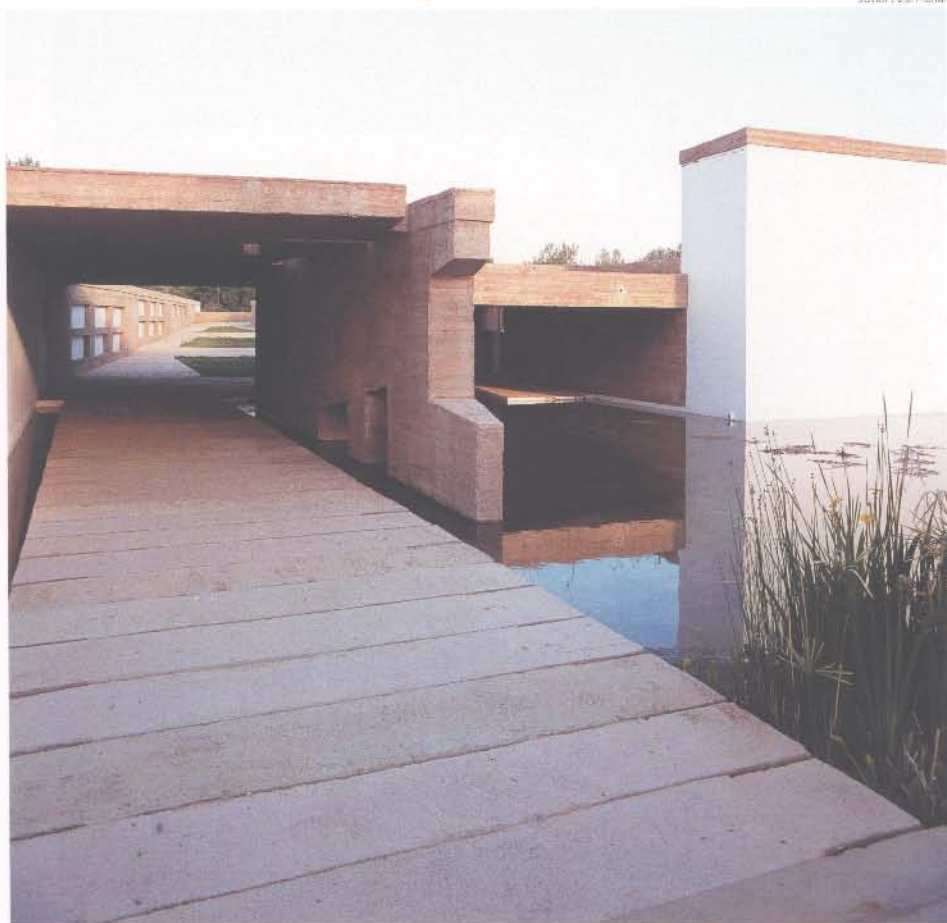
Acceso junto al estanque Entrance by pond
