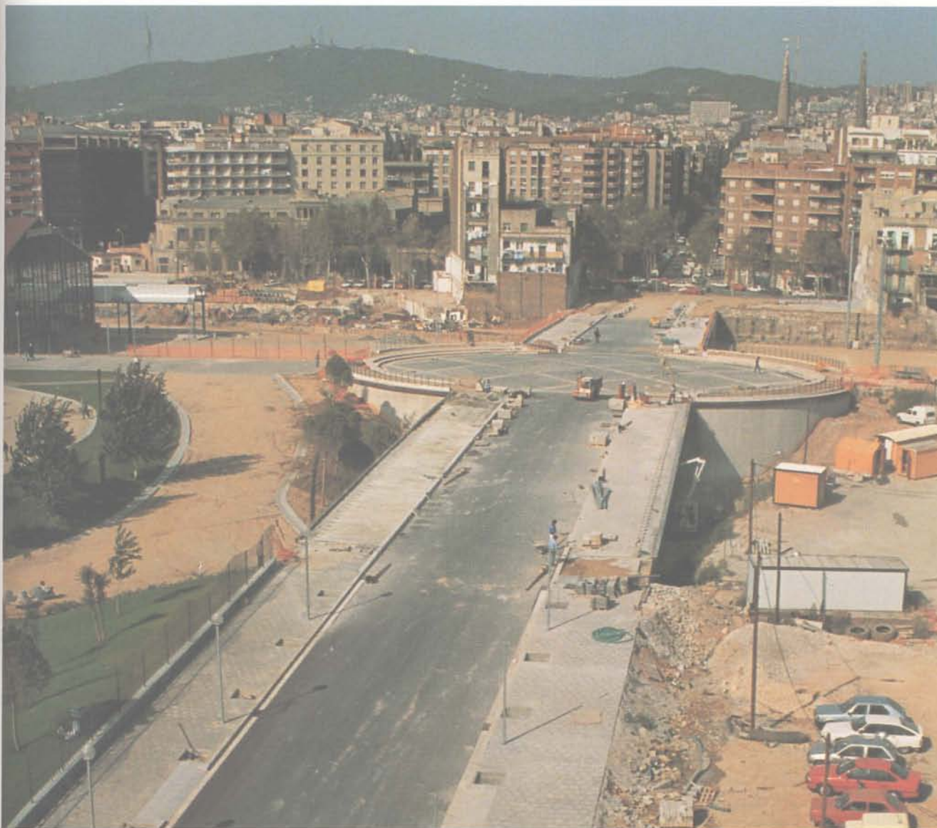
Fig. 11. Vista longitudinal del Puente de la calle Sardenya. En el centro, la plaza.
