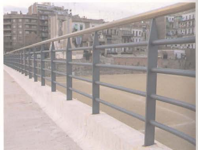
Fig. 15. Barandilla de los puentes.
