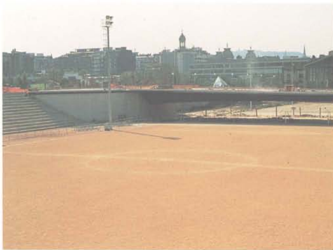
Fig. 13. Encuentro de uno de los puentes con la nueva plaza.
