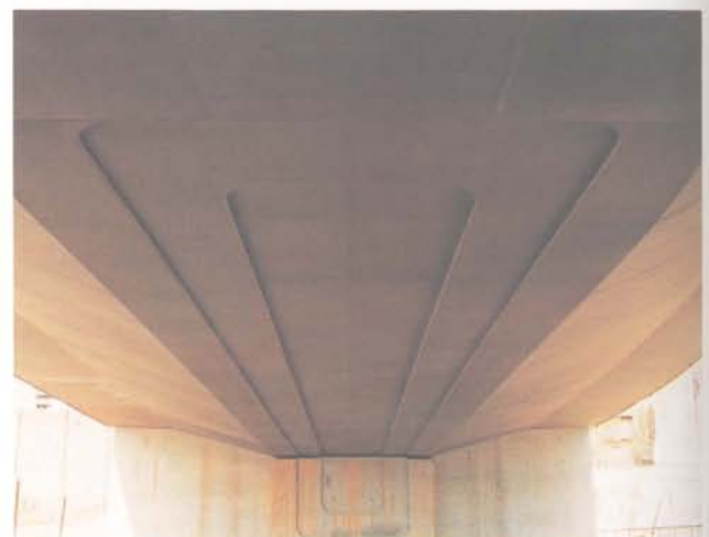
Fig. 16. Tratamiento formal del intradós de los puentes y del frente de los estribos.
