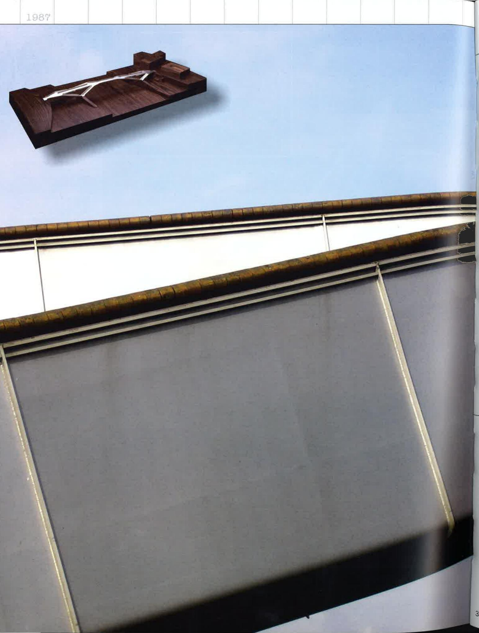
La longitud total de la pasarela principal es de 142,25 m., con una distancia entre ejes de apoyo del vano central de 84,00 m. Los **anchos útiles** son de 6,50 m. para el vial peatonal central y 3,00 m. para las rampas laterales, muy superiores a las inicialmente exigidas en el concurso restringido convocado en 1995 y del que resultó ganadora esta propuesta.
